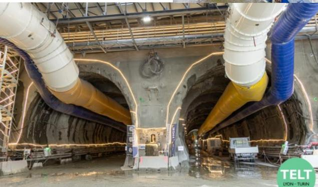
Les travaux d'excavation comprennent 2 galeries de 2,8 km (dont 500 m sous voûte parapluie), 11 rameaux de communication et 6 niches ; les matériaux seront évacués par bande transporteuse (en cours de construction) vers un site de traitement dédié. Le creusement, commencé le 5/12/2022, a dépassé les 200 mètres sur chaque tube au début de l'été 2023.
